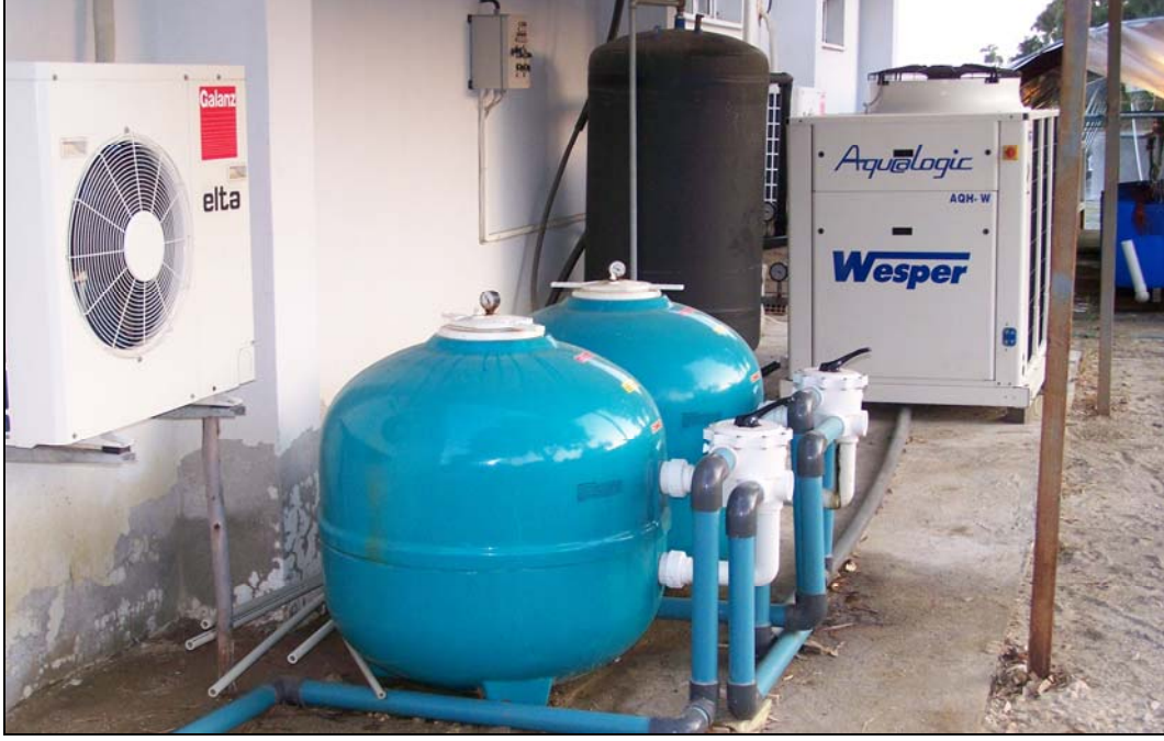
Şekil 4. Araştırma İstasyonumuzda bulunan ve denememizde kullandığımız kum filtreleri ve deniz suyu ısıtma/soğutma sistemi.
