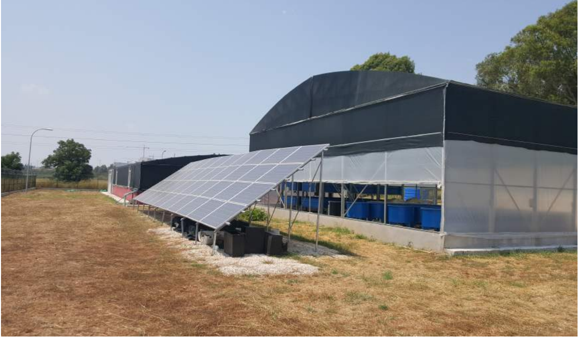
Şekil 3.1. Proje bütçesinden inşa edilen 200 m 2 boyutunda sera, 10 KW elektrik üretebilen solar sistem ve sera içerisinde bulunan RAS sistemlerinin sera dışından görüntüleri.
